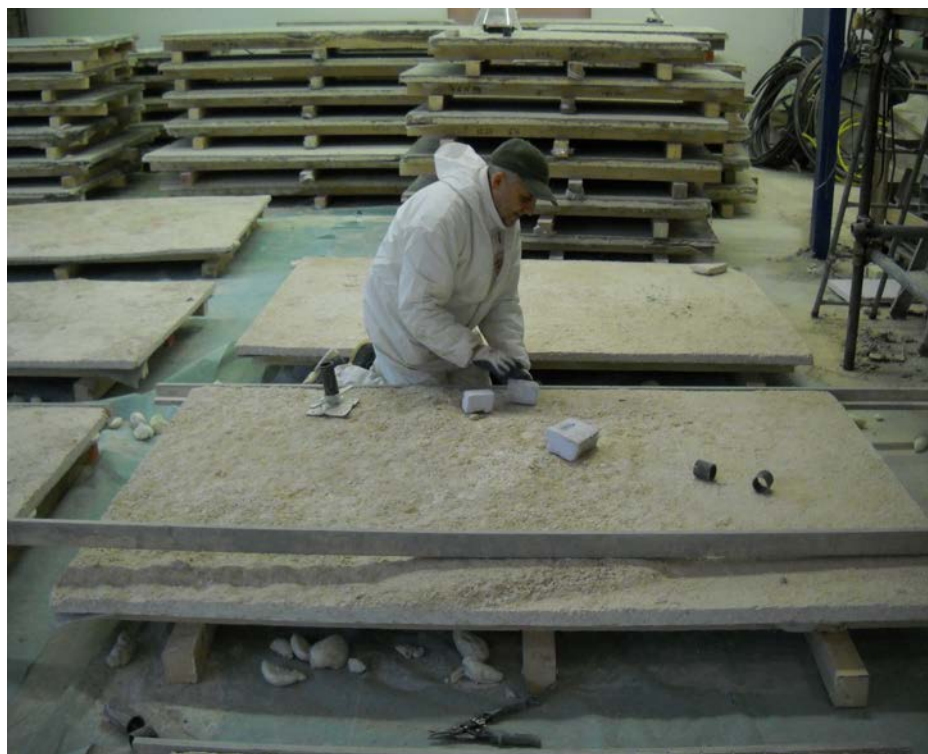
4. Consolidamento delle lastre ed intervento di rettificazione del fondo delle lastre.
