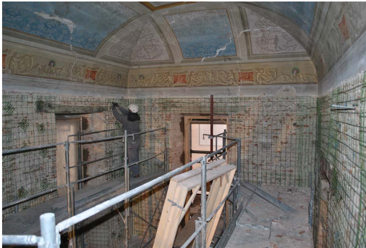
17. Fase di posa della rete Fibrenet in fibra di vetro per il consolidamento delle murature.
