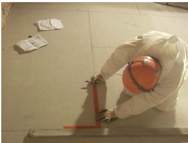
2a,b,c. Preparazione al taglio ed allo strappo. Predisposizione del disegno di taglio. Fase di taglio con sega a disco.
