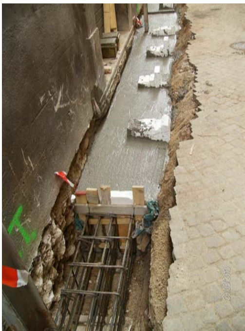
14. SOPRA Sottofondazioni dell'edificio. 15. A LATO Rimontaggio del rivestimento.
