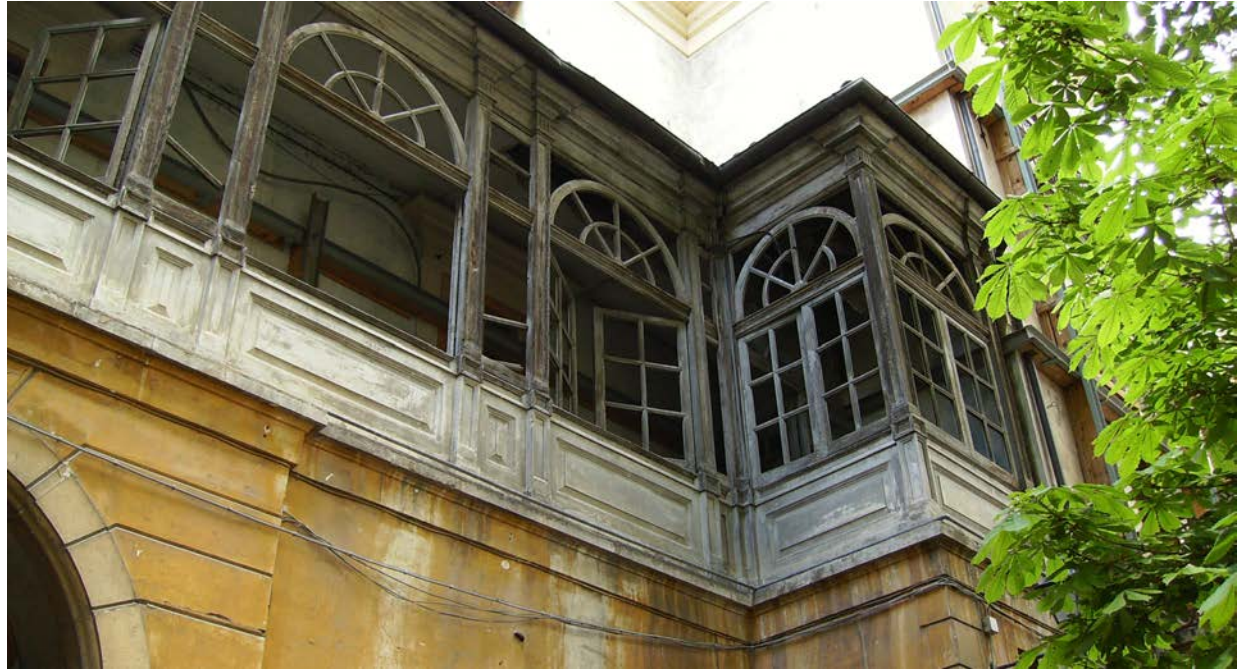
16a,b. Gli elementi lignei prima e dopo l'intervento di restauro.
