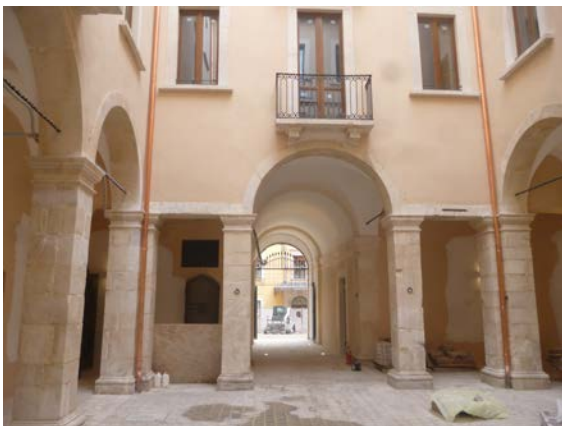
12. SOPRA Portico centrale dopo l'intervento. 13. A LATO Fase di puntellamento dei pilastri.
