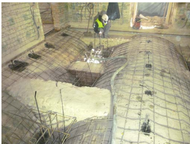
5. Rinforzo delle volte sottostanti la pavimentazione in terrazzo con FRP. 6. Consolidamento delle volte. 7. Restauro dei dipinti all'intradosso delle volte consolidate.
