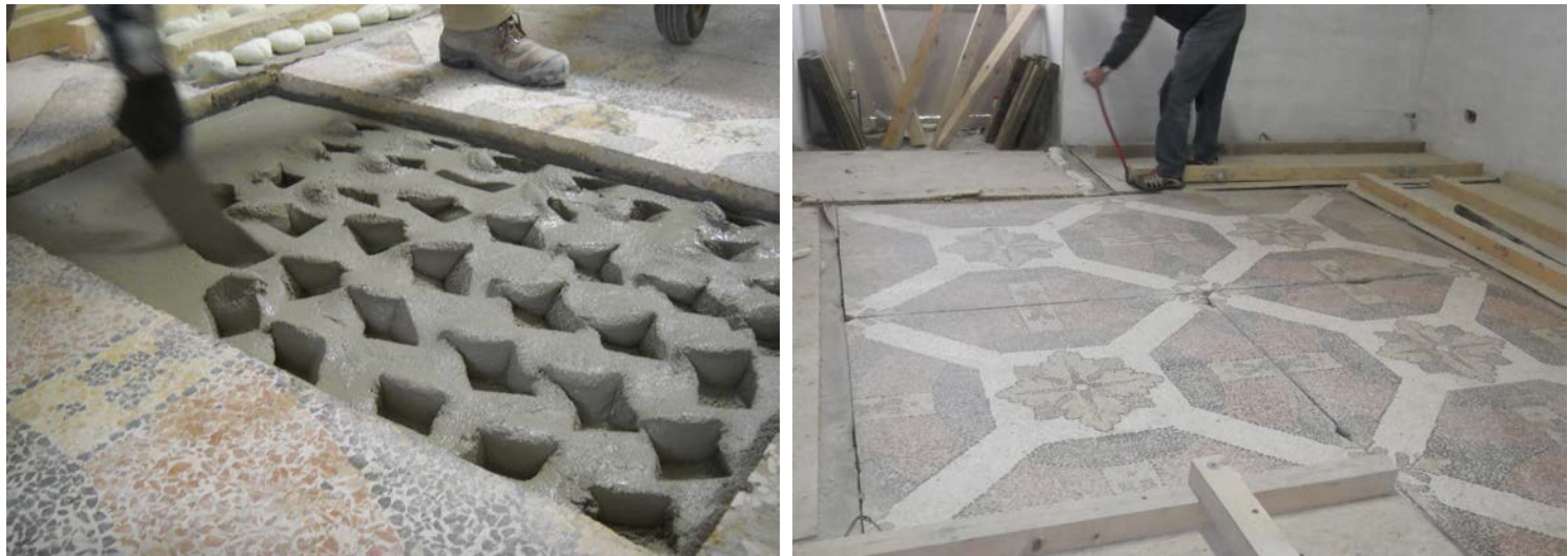
6,7. Posizionamento delle lastre di pavimento dopo interventi di consolidamento delle stesse e del rinforzo delle volte sottostanti.
