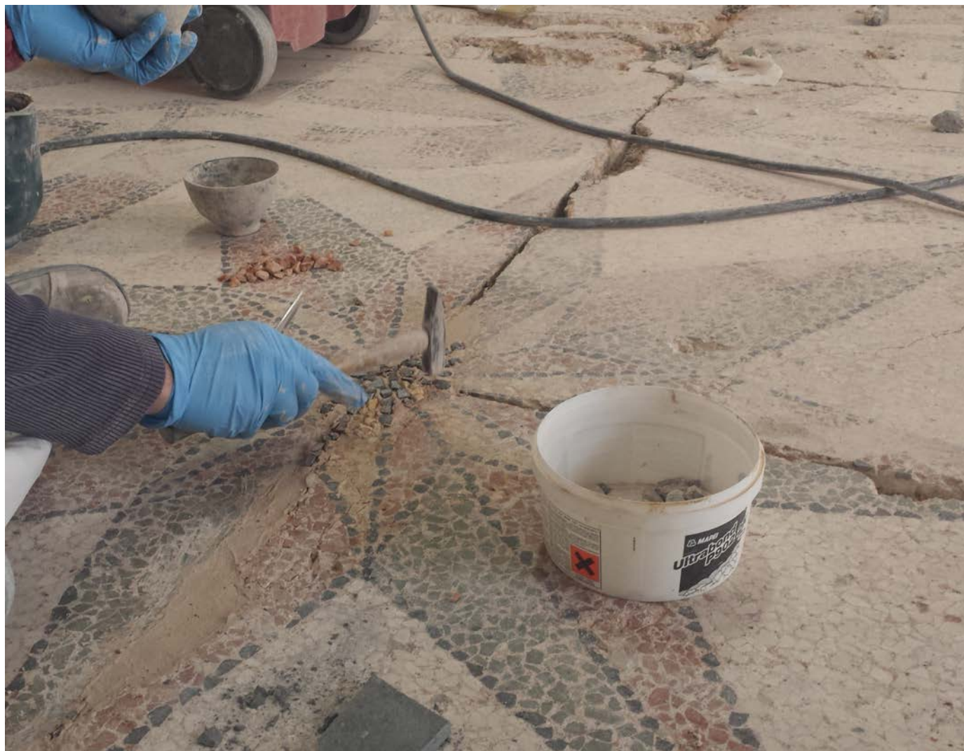
8a,b. Fase di risarcitura delle commessure.
