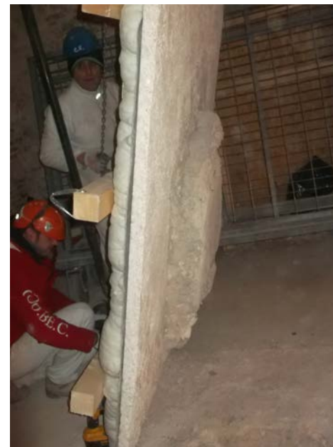
2a,b,c. Preparazione al taglio ed allo strappo. Predisposizione del disegno di taglio. Fase di taglio con sega a disco.
