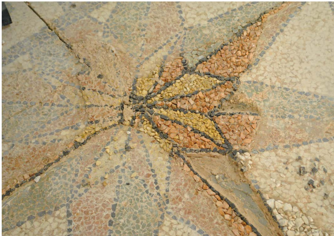
9. Stuccatura e risarcitura delle lacune. 10. Fase di levigatura della superficie a terrazzo. 11. Lucidatura finale della pavimentazione.
