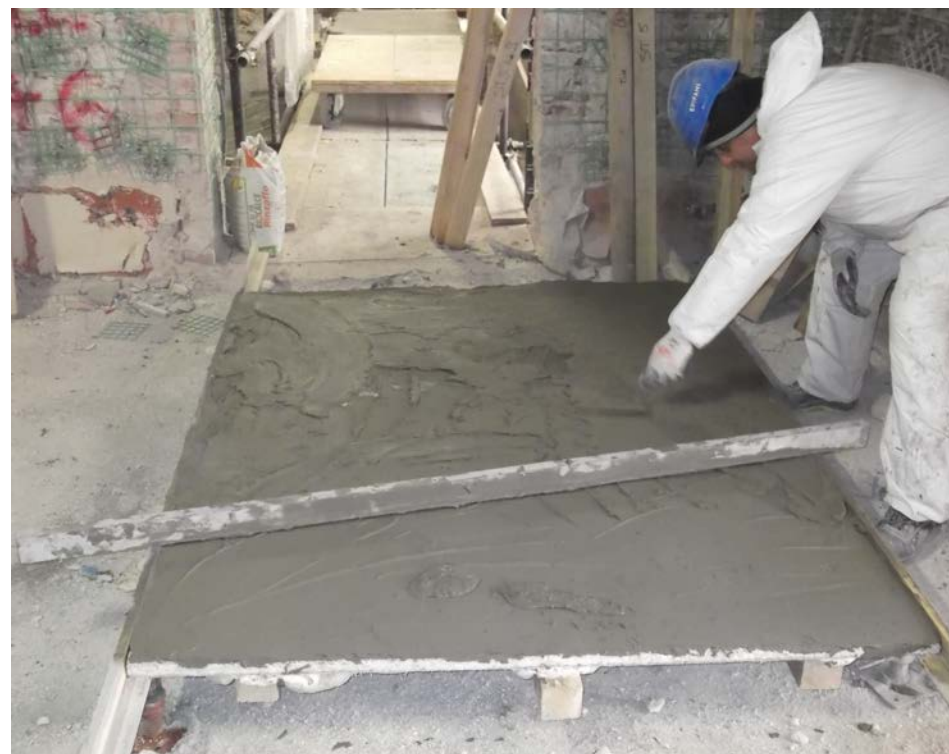
4. Consolidamento delle lastre ed intervento di rettificazione del fondo delle lastre.
