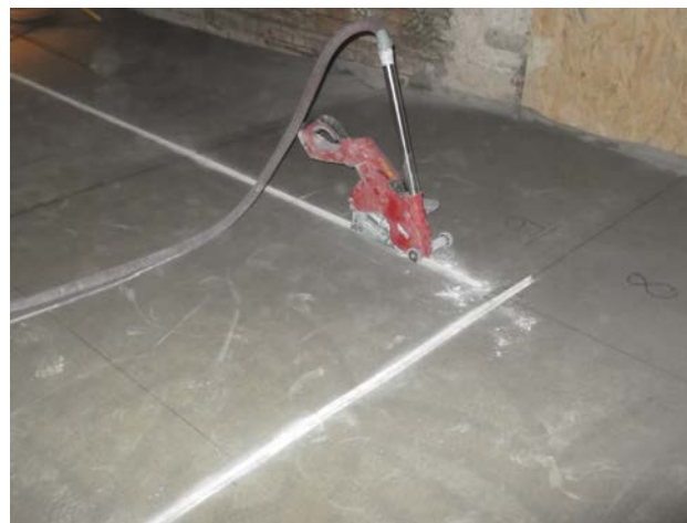
2a,b,c. Preparazione al taglio ed allo strappo. Predisposizione del disegno di taglio. Fase di taglio con sega a disco.
